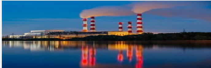
ДТЭК [Кураховская ТЭС, Зуевская ТЭС, Луганская ТЭС] [Украина] Электростанции. Электроснабжение и электропривод.
