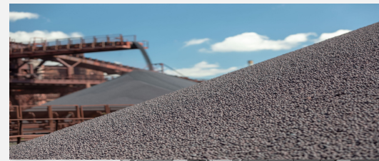
ОАО «Полтавский ГОК» [Украина] Горно-обогатительный комбинат. Электроснабжение, автоматизация.
