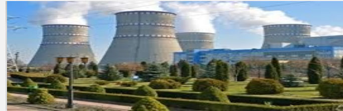
Энергоатом [Украина] Атомные электростанции. Электроснабжение.
