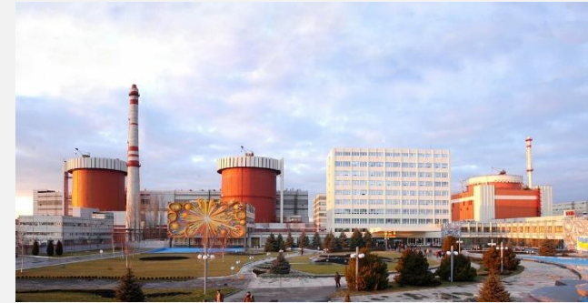
Firma Państwowa 'ENERGOATOM' (Ukraina) System sterowania pomp wodnych dla Południowo-Ukraińskiej Elektrowni Atomowej.
