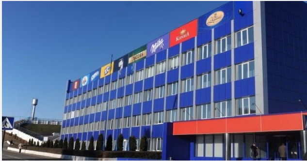
Mondelez International (USA) Remont linii produkcyjnych Barny i Oreo w zakładach w Trościancu. System gwarantowanego zasilania.
